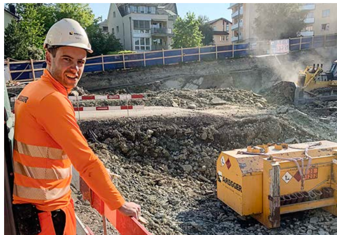
Polier Rafael Frei begutachtet den Baufortschritt im Wesemlin.
