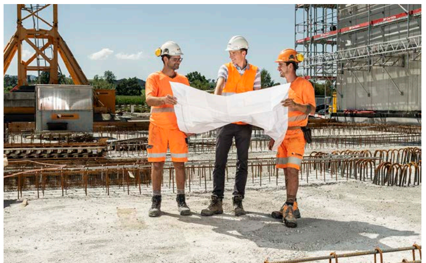
Bauführer Marco Imgrüt (Mitte) mit Polier Matthias Graber (links) und Vorarbeiter Reto Achermann auf der Baustelle des neuen Werkhofs in Buttisholz.
