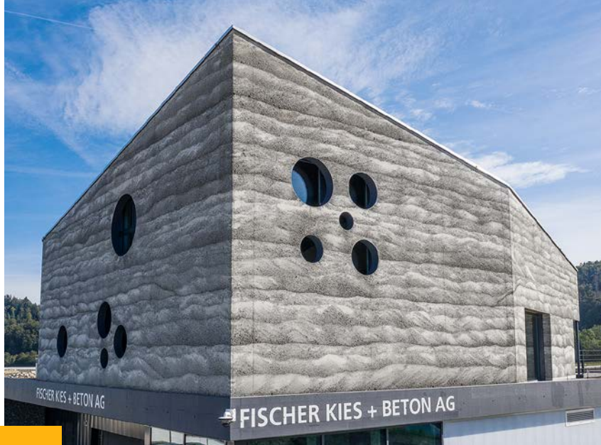
Ein Blickfang: Die mit Stampfbeton gefertigte Fassade des «Steins».
