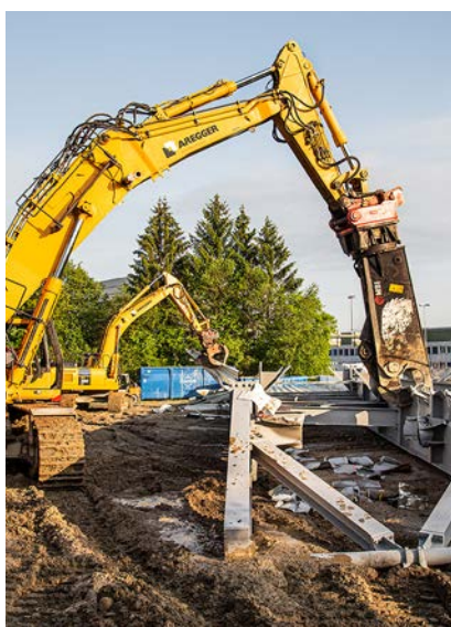
60 Tonnen schwere Stahlträger
