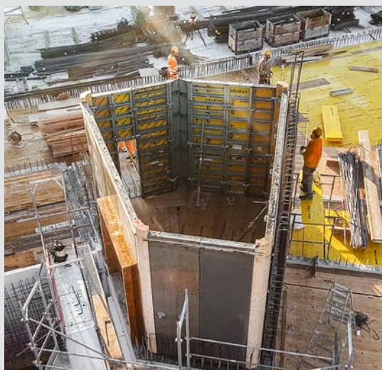
Anspruchsvolle Schalung des unkonventionellen Treppenhaukerns.
