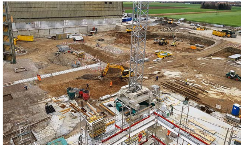
Gewaltige Dimensionen beim Aushub für die Migros Neuendorf.
