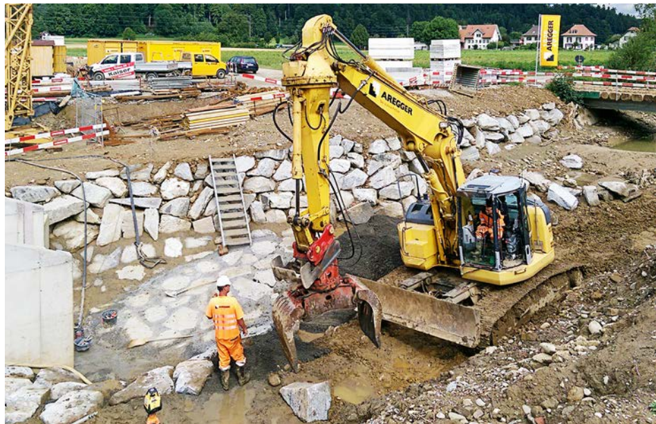
Parallel zur Sure wird der Fischeaufstieg realisiert.
